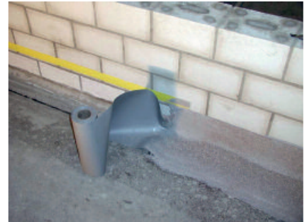
Verkleben von PCI Pecitape 3000 mit Epoxikleber
