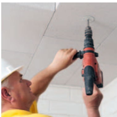
Gegebenenfalls verdübeln mit Multipor Deckenbefestigung für Decken MIT Brand-schutzanforderungen
