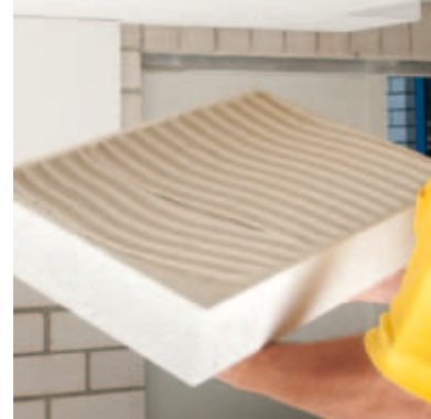
Steghöhe des Leichtmörtels ca. 8–10 mm. Unebenheiten im Untergrund bis 3 mm können so ausgeglichen werden.
