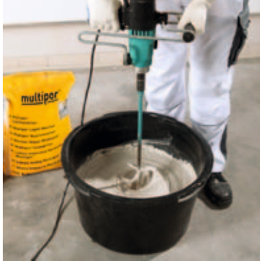
20 kg Leichtmörtel mit 8 l Wasser (Markierung am Messeimer) ergeben 30 l Klebemörtel.
