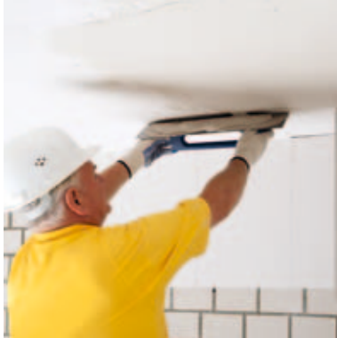
Multipor Leichtmörtel aufziehen
