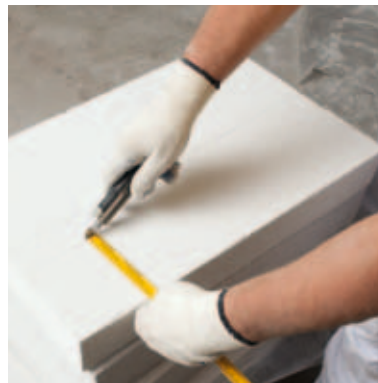
Platte ausklinken bei vorhandenen Leitungen
