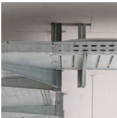
Befestigung eines Kabelträgers
