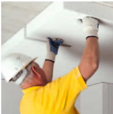
Multipor Mineraldämmplatte mit Leichtmörtel sofort im Abstand von ca. 2 cm zur nächsten Platte an die Decke ansetzen und einschwimmen
