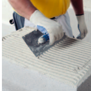
Mit Zahntraufel (10er- oder 12er-Zahnung) vollflächig auftragen und durchkämmen
